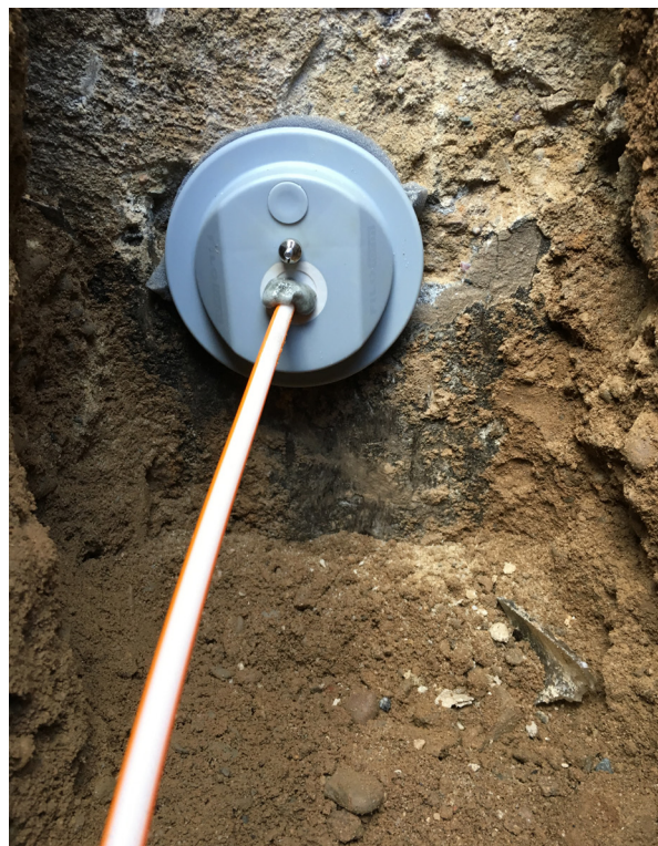
Abbildung 4: unterirdische Hauseinführung für Mikrorohre
