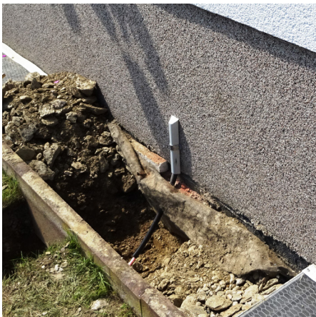
Abbildung 6: Beispiel für eine oberirdische Hauseinführung und schematischer Querschnitt
